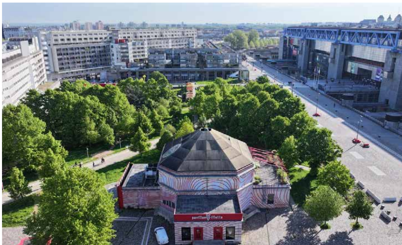
Maison de la Villette - parc de la Villette en drone - photo© Elie Delpit et Louis Didaux
